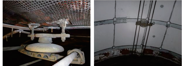
Photo. 12 下束(左:移設前, 右:移設後)
