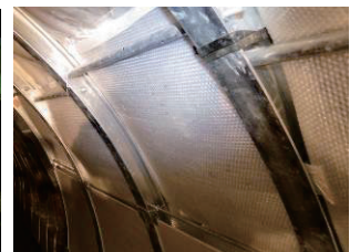
Photo. 5 断熱材設置状況
