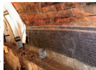
Photo. 17 ③裏面排水材設置
