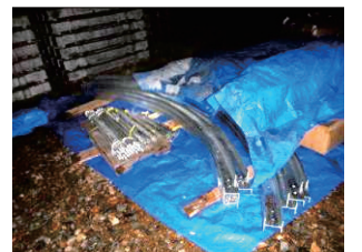
Photo. 7 支保工および 径間パイプ
