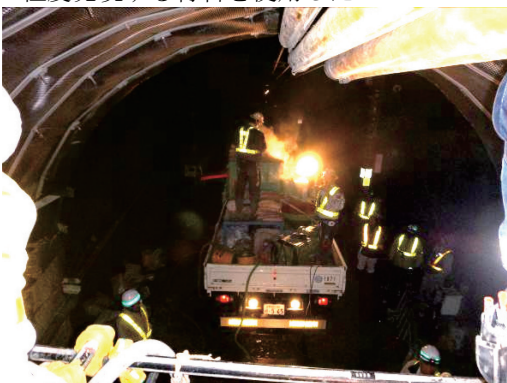
Photo. 11 軌陸車に搭載したモルタルポンプ
