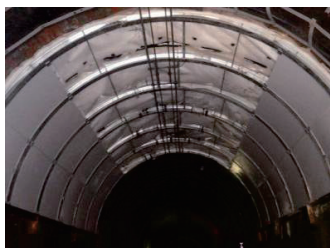
Photo. 21 ⑥薄型パネル設置 (左右2段分)
