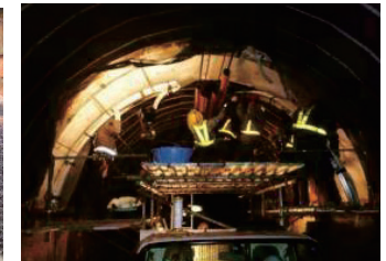
Photo. 18 ④⑤支保工・防水シート設置
