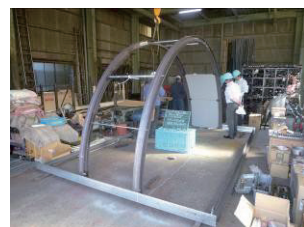
Photo. 6 支保工仮組み
