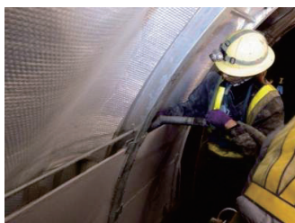
Photo. 22 ⑦モルタル充填
