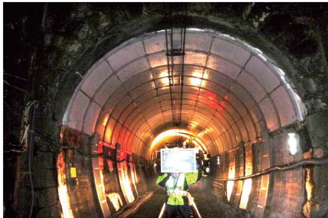
Photo. 23 補修工完了
