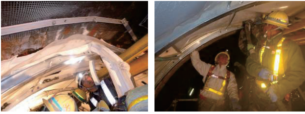
Photo. 8 プレロードジャケット設置, 右:モルタル充填 (左:プレロードジャケット設置, 右:モルタル充填)
