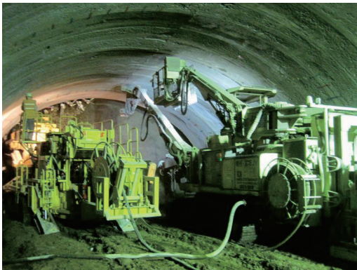
Photo. 1 リングカット掘削機配置
