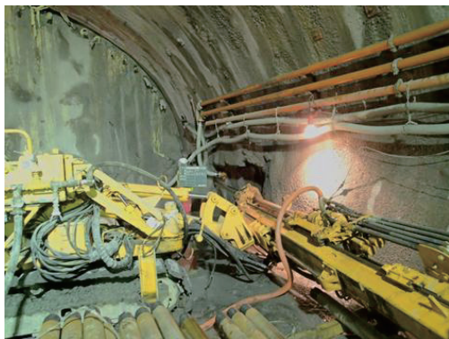
Photo. 4 水抜きボーリング施工状況
