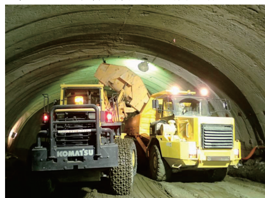
Photo. 2 ずり積み込み状況
