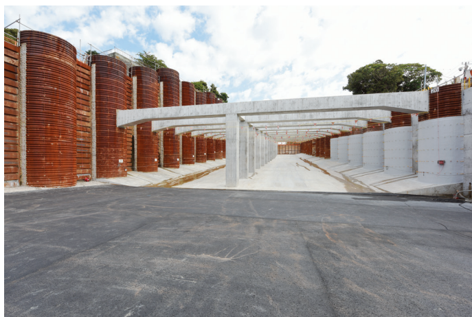
深礎擁壁完成時
