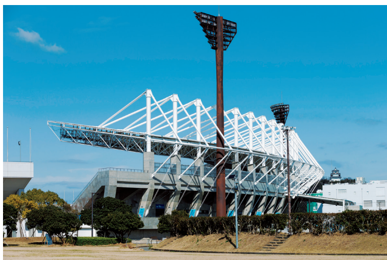
バックスタンド北東側より全景
