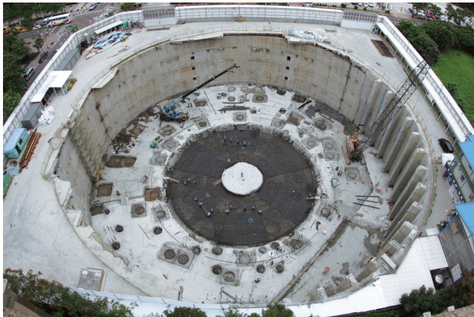
新設土留め壁完成状況
