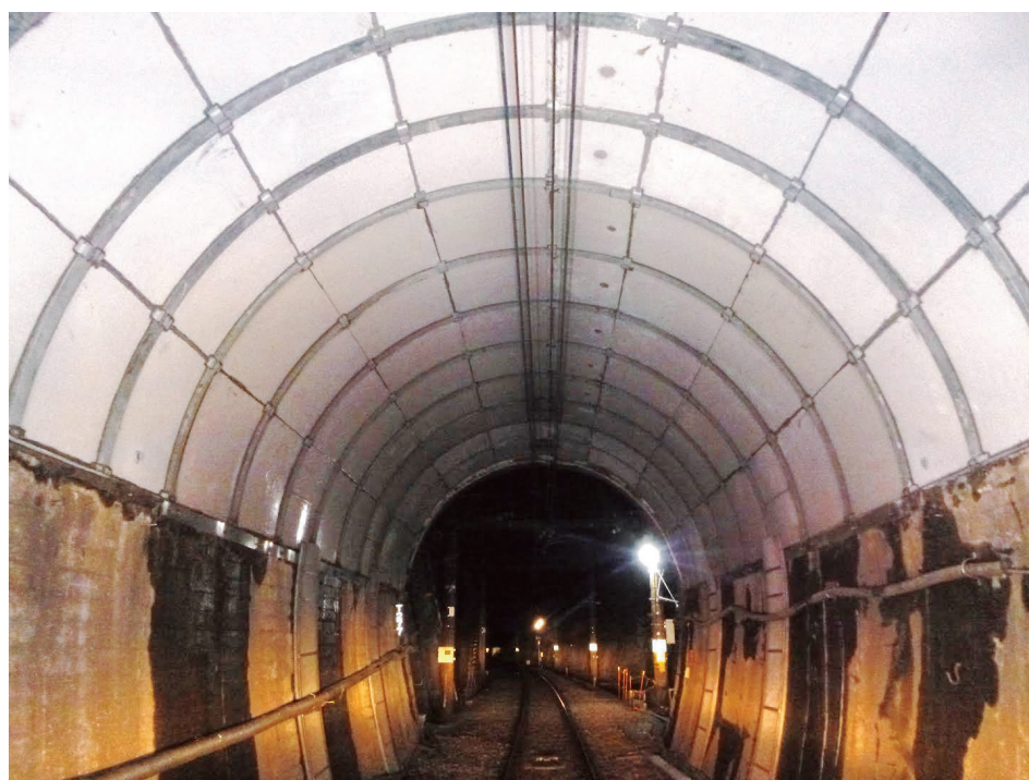
補修工完了状況
