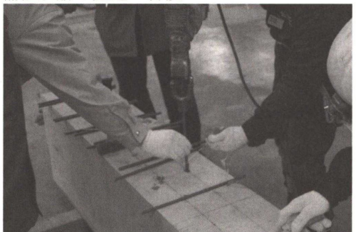
Fig. 5 あと補強の施工状況(異形鉄筋)
