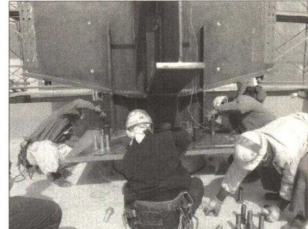
Photo. 5 鉄骨取り合い
