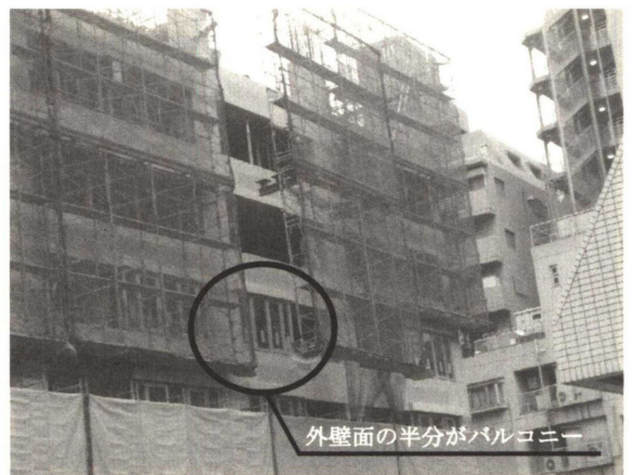
Photo. 4. 6 連層吊足場せり上げ状況状況
