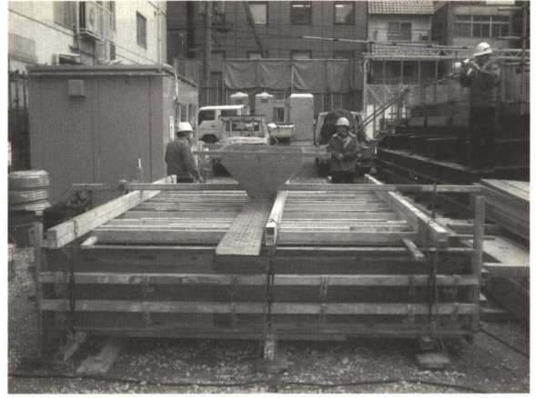
Photo. 4.7 免震部材下部充填施工試験状況
