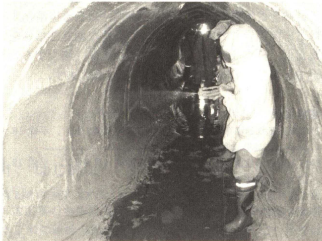
Photo. 8 ポリウレア施工状況
