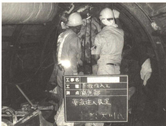
Photo. 5 注入式フォアポーリング施工状況
