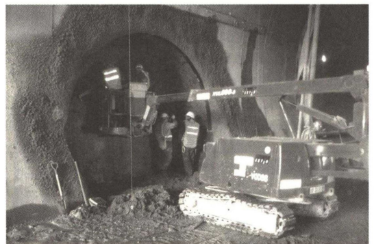
Photo. 9 支保工建て込み状況
