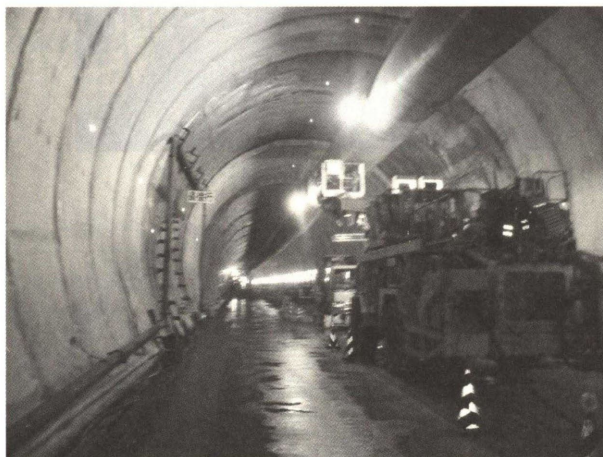
Photo. 5 施工スペース全景
