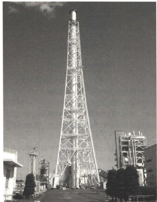
Photo.1 撤去前の煙突全景
