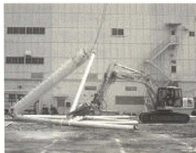
Photo. 7 鉄塔材の小分割解体状況
