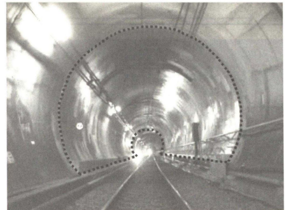
Photo. 11 本工事施工完了時
