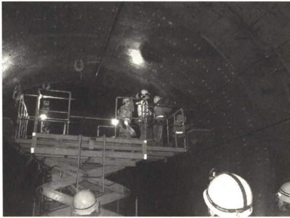
Photo. 4 覆工板取付状況
