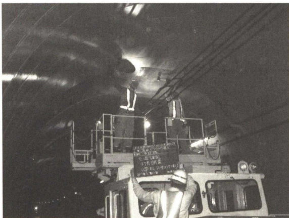
Photo. 9 裏込めグラウト硬化後打音確認状況
