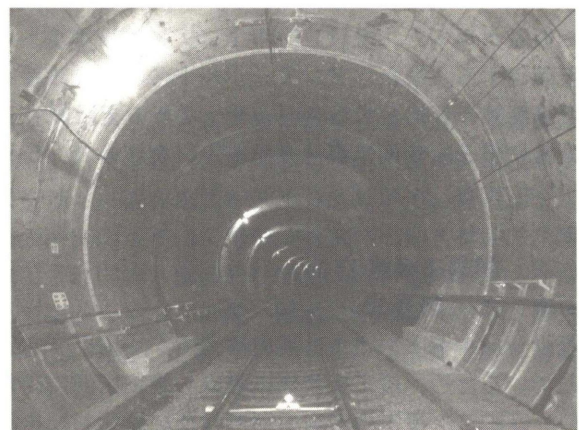
Photo. 3 試験工事全景
