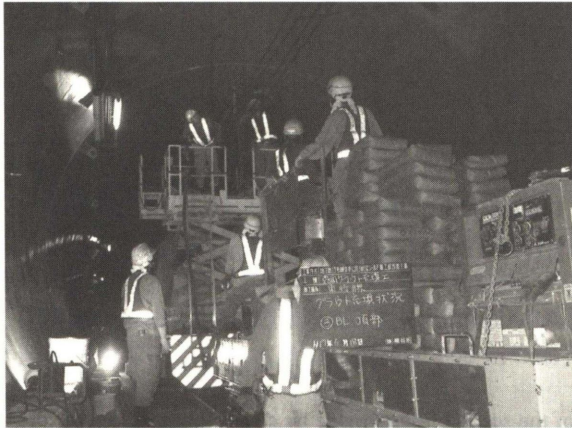
Photo. 8 裏込めグラウト注入状況
