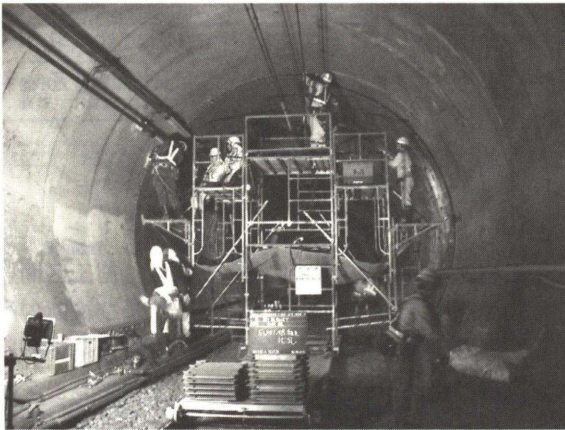
Photo. 5 覆工板取付施工状況
