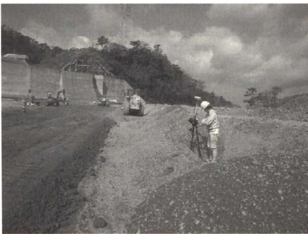
photo. 6.1.1 GPS 測量状況
