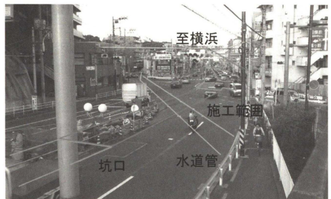
photo.1 交差点全景①
