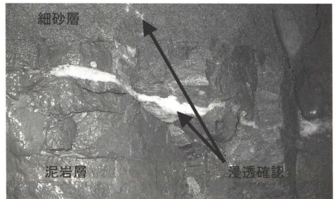
photo. 4 薬液注入浸透効果確認
