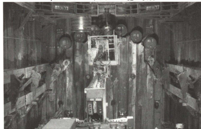
photo. 7 補助工法1シフト完了・掘削開始前
