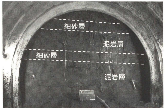
photo. 3 切羽状況（湧水無し）
