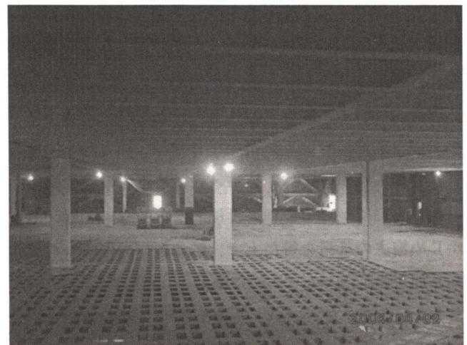
Photo. 10 FAB 棟格子梁施工状況
