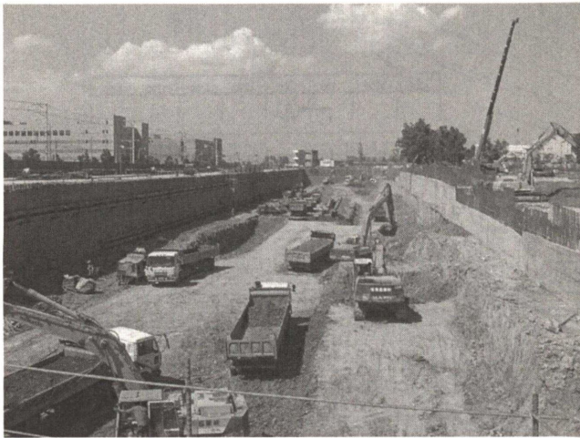
Photo. 1 掘削工事状況
