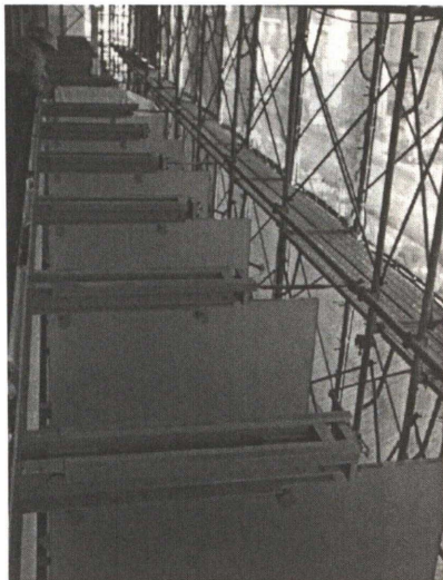
Photo. 8 リフがら施工完了
