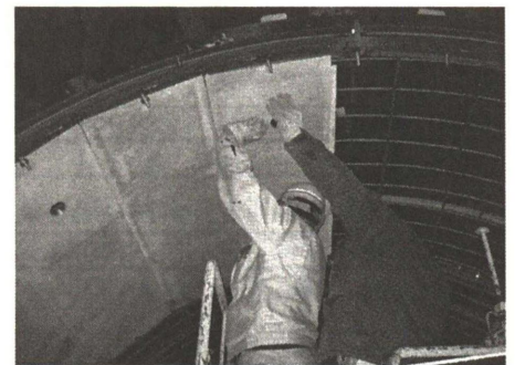
Photo.1 覆工板の施工状況
