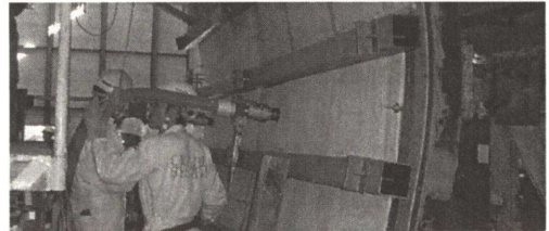
Photo.2 模擬トンネルへの打設状況
