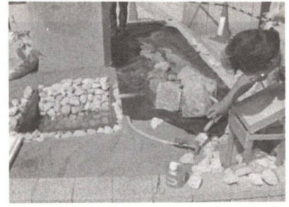
水田およびせせらぎへの給水管接続
