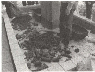
パーライトおよび備長炭敷き均し
