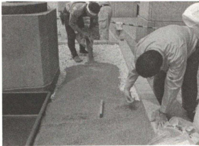
客土敷き均し
