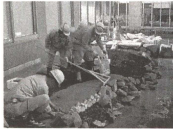
特殊用土敷き均し
