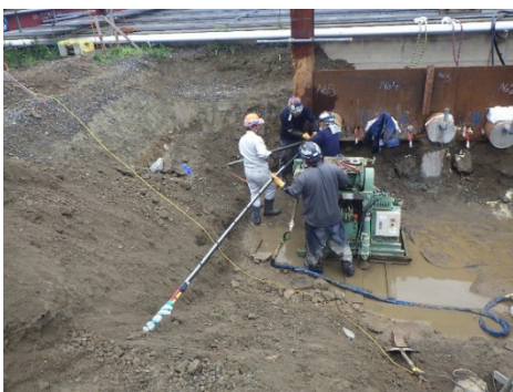
Photo. 5 GRPボルト挿入状況
