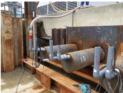
Photo. 3 モルタル充填状況
