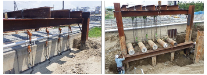
Photo. 4 吊り防護状況 (左-小ダクト 右-大ダクト)
