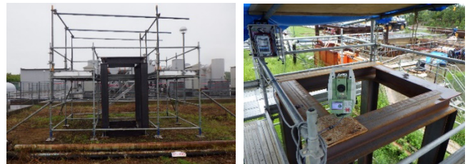
Photo. 7 自動計測機設置
