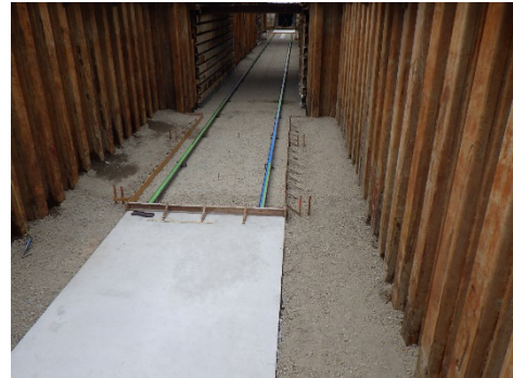
Photo. 9 横引きレール設置
