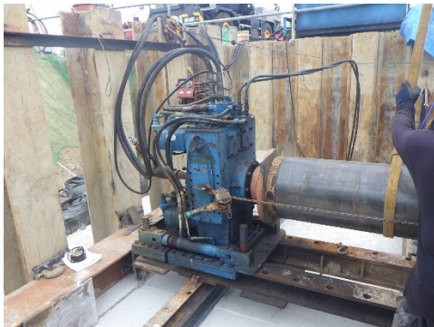
Photo. 2 鋼管推進機
