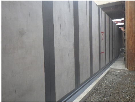
Photo. 12 プライマー塗布完了全景
