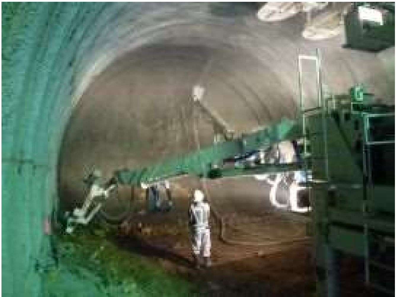
写真 1 従来の吹付け状況
