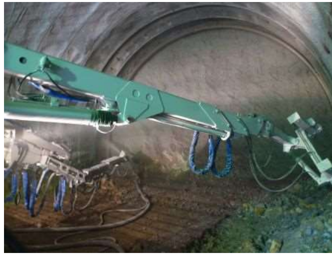
写真3 遠隔操作による吹きつけ状況
