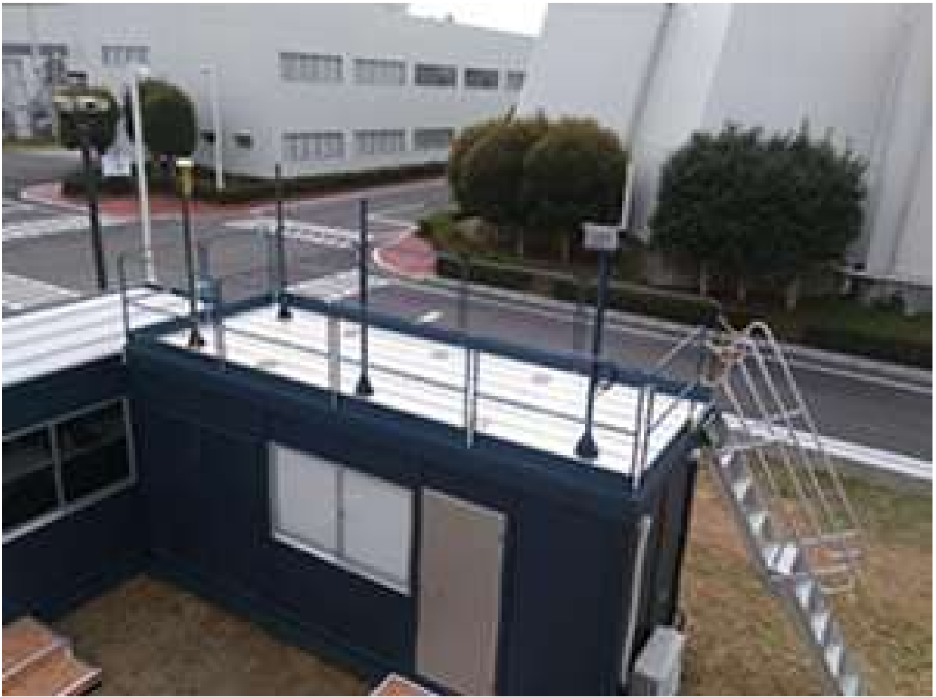
屋上ステージ設備
