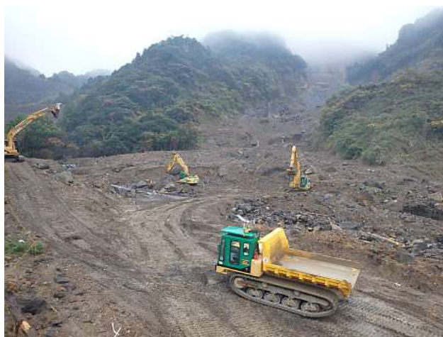
現地無人化施工状況
