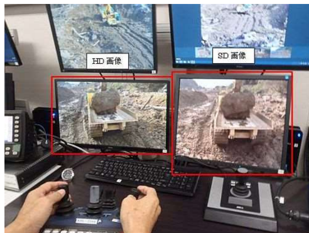
HDカメラによる施工状況
