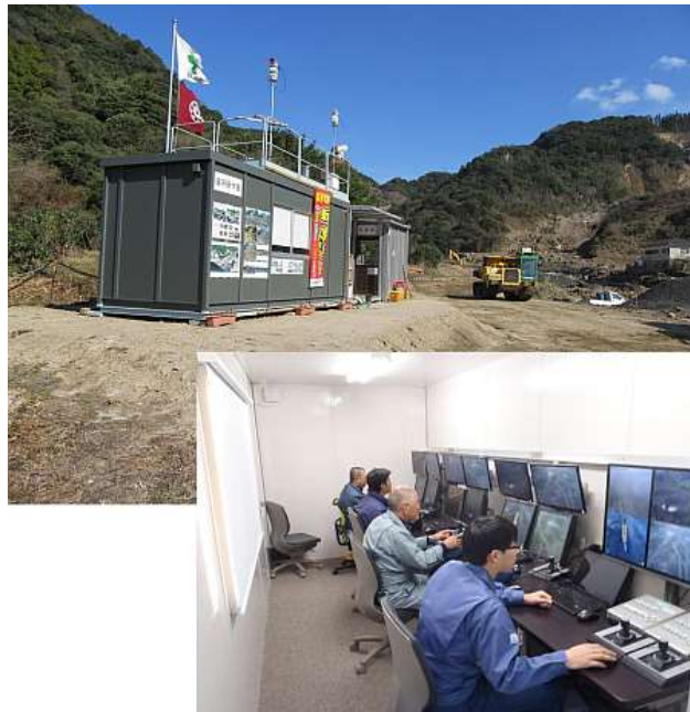
高機能遠隔操作室
