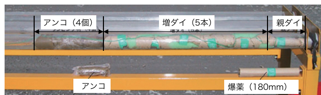
模擬の爆薬による遠隔装填システムによる密装填状況
