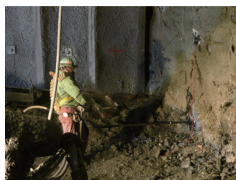
遠隔装填による装薬作業
