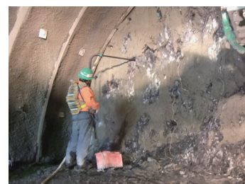
遠隔装填による装薬作業
