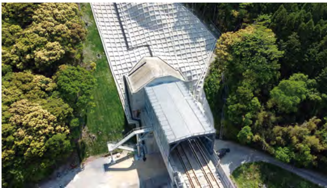
九州新幹線(西九州)、17k5・44k2間線路諸設備他
