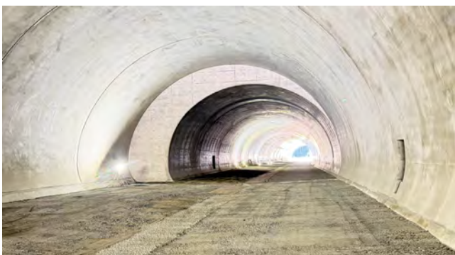
すさみ串本道路江住第一トンネル工事
