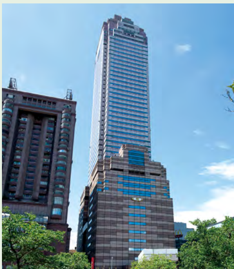
超高層大型複合商業ビル 新光人寿大楼
