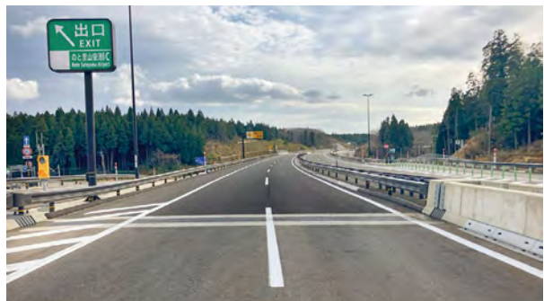
プレキャスト踏掛版にて早期復旧を実現した能越自動車道
