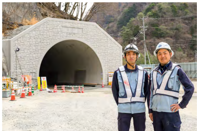
現場の若手社員(トンネル坑口)
