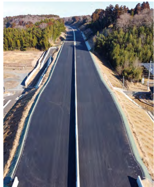
東関東自動車道 塔ヶ崎工事
