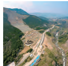
2017 阿蘇大橋地区 斜面防災対策工事
