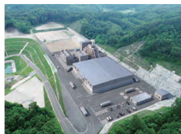
飯館みらい発電所
