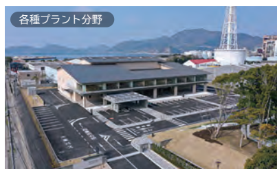
想い出の杜ホール (山口県) 発注者：周南地区衛生施設組合
