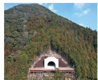
奥瀬道路(3期)2号トンネル他工事 発注者: 国土交通省近畿地方整備局
