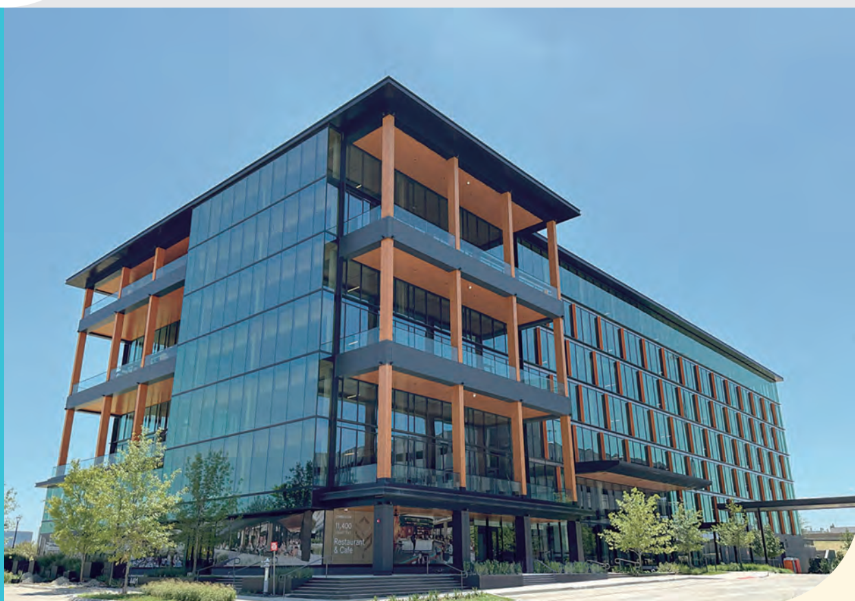
熊谷組が開発に参画した米ダラス近郊で最大規模の木造7階建てESG配慮型オフィス
