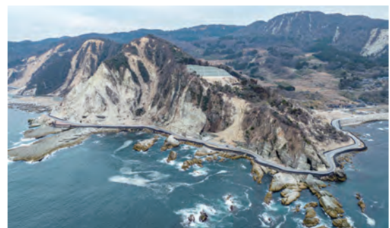
令和6年能登半島地震 国道249号啓開作業その2工事 発注者: 国土交通省北陸地方整備局
