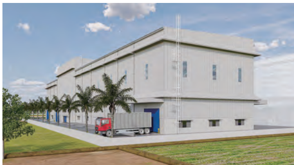
施工中の日系企業の工場
