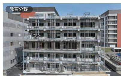
未来知実証センター (石川県) 発注者：国立大学法人金沢大学
