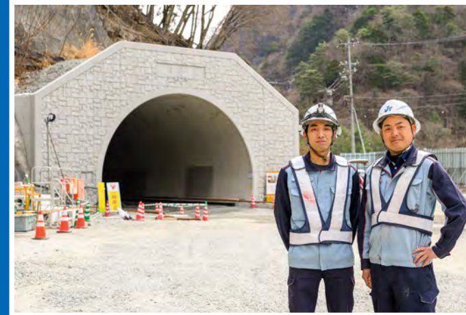
現場の若手社員(トンネル坑口)
