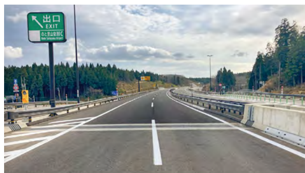
プレキャスト踏掛版にて早期復旧を実現した能越自動車道
