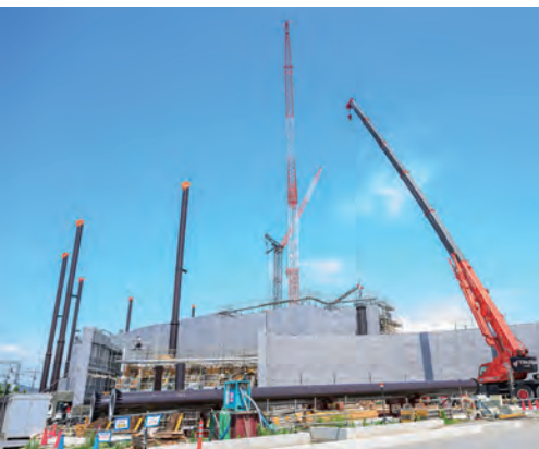
「日鉄鋼板SGLスタジアム尼崎」野球場
