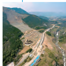
2017 阿蘇大橋地区 斜面防災対策工事
