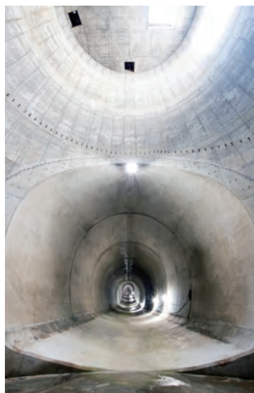
平成30-32年度 日下川新規放水路(吐口側)工事(高知県) 発注者:国土交通省
