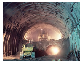
1977 上越新幹線中山トンネル貫通
