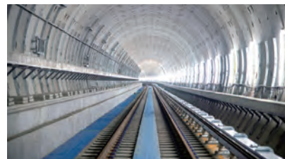
北大阪急行線の延伸事業のうち土木工事(大阪府) 発注者:北大阪急行電鉄株式会社
