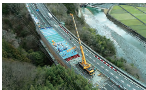
東名高速道路（特定更新等）酒匂川橋他2橋床版取替工事
