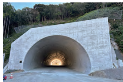
すさみ串本道路有田トンネル他工事(和歌山県) 発注者:国土交通省
