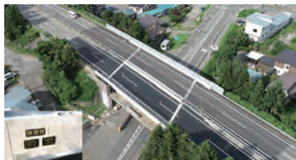
東北自動車道 陣場橋床版修繕工事(秋田県) 発注者:東日本高速道路株式会社
