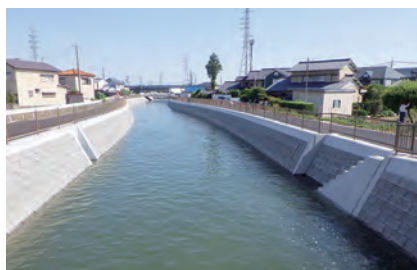
新濃尾(二期)農地防災事業新木津用水路 小牧東田中工区(その2)改修工事(愛知県) 発注者:農林水産省
