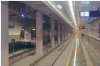
デリー地下鉄建設工事
