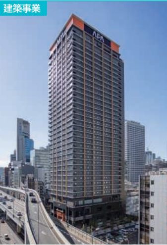
建築事業 アバホテル&リゾート 〈大阪梅田駅タワー〉 (大阪府) 発注者: アバホーム (株) アバマンション (株)
