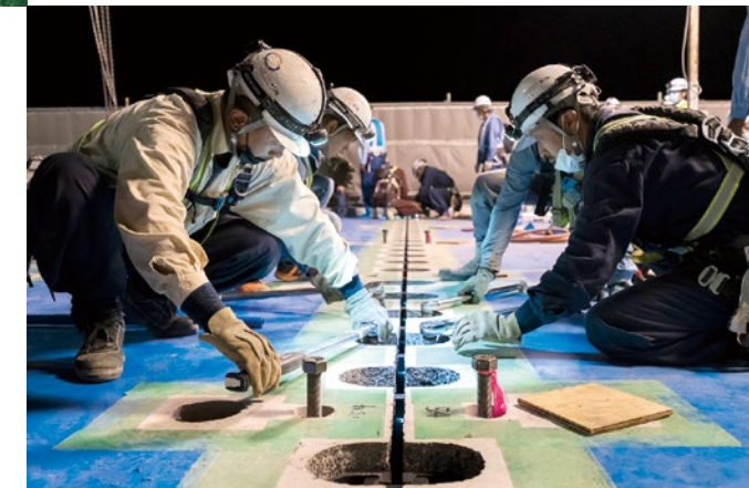
継手の接合作業
