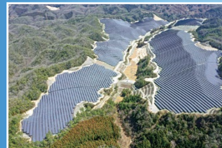
パンフィコ・エナジー 豊田メガソーラー発電所土建工事
