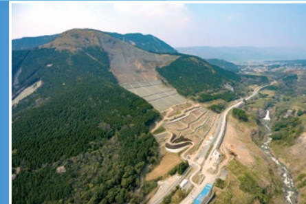
阿蘇大橋地区斜面对策工事
