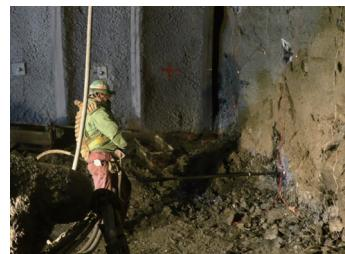
遠隔装填による装薬作業
