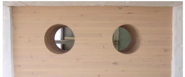
日集協の木質ハイブリッド集成材に住友林業の梁貫通孔内部を耐火被覆する技術を組み合わせて、2021年10月22日に有孔梁の新規大臣認定を共同取得しました。梁に配管設備を貫通でき、また貫通孔内部の不燃材は外側からは見えないため意匠性が高まります。
