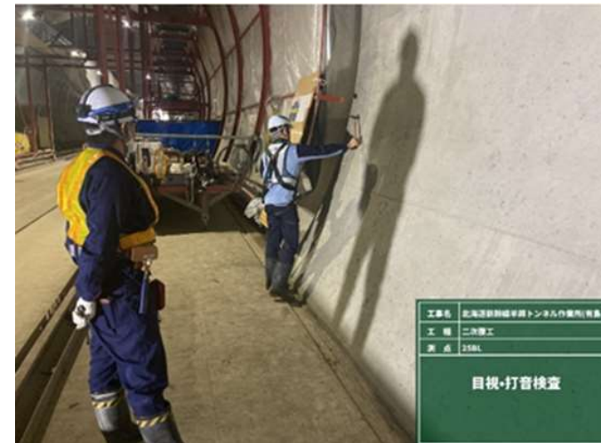
目視・打音検査：覆工コンクリート（二次）
