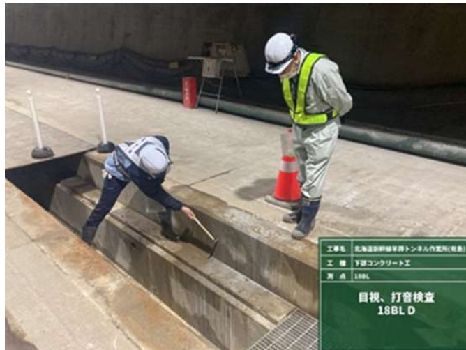
目視・打音検査：下部コンクリート（二次）
