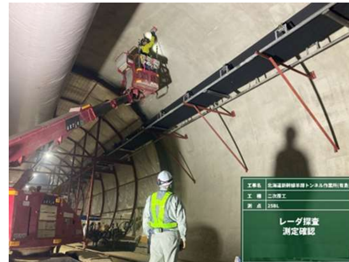
覆工電磁波レーダー探査による空洞調査
