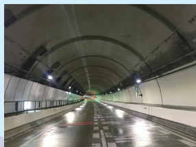
高速2号東山線トンネル天井板撤去工事
