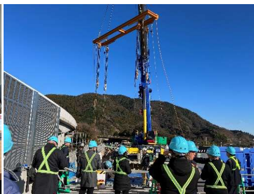
アナリスト向け建設現場見学会
