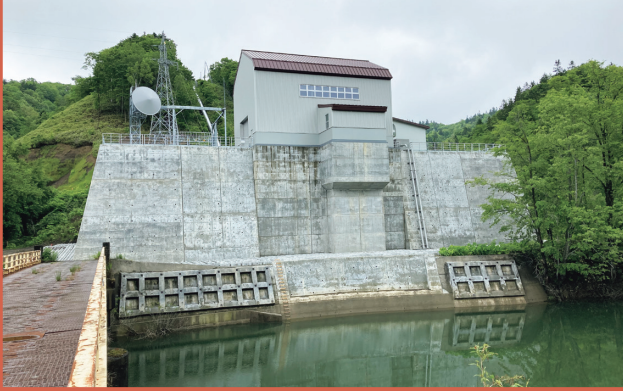
熊追発電所改造工事
