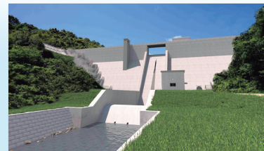
春遠ダム(春遠第1ダム)本体建設工事
