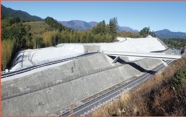
中部横断自動車道吉原地区切土のり面災害復旧工事
