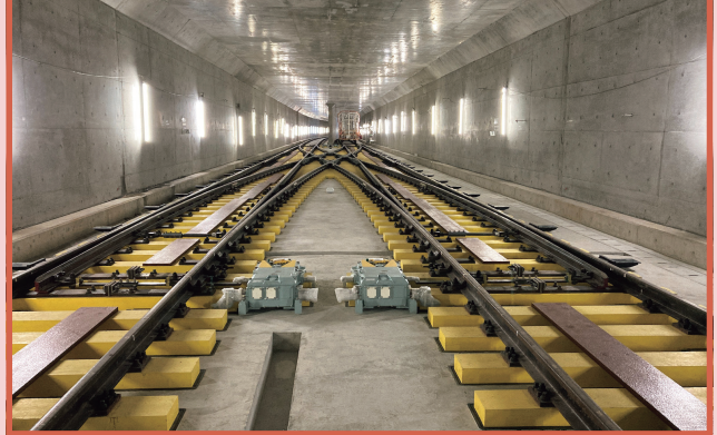
銀座線浅草駅折返し線延伸に伴う土木工事
