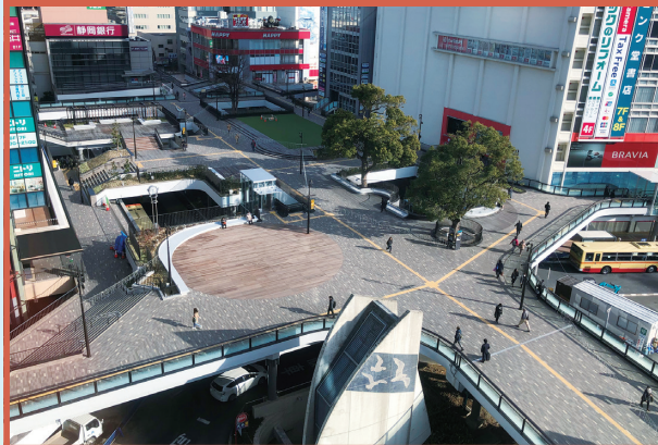
藤沢駅北口ペDESTリアンデッキ再整備工事（神奈川県）
