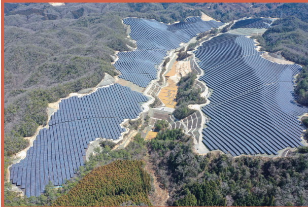
パシフィコ・エナジー豊田メガソーラー発電所土工工事（愛知県）
