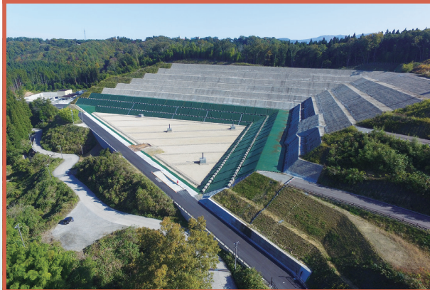
産業廃棄物管理型最終処分場埋立地造成工事（石川県）
