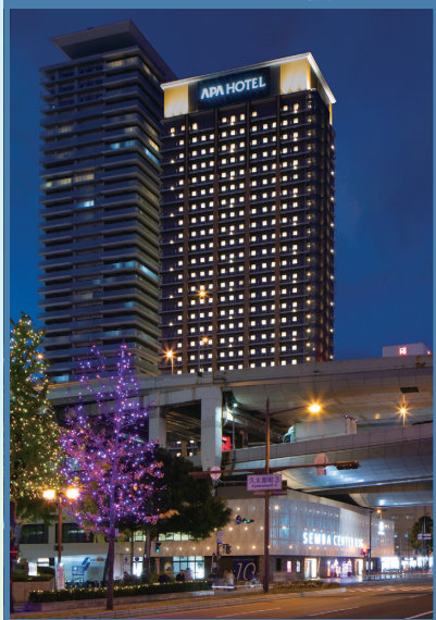
アパホテル&リゾート〈御堂筋本町駅タワー〉（大阪府）
