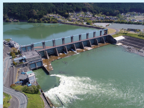
船明ダム下流洗掘対策工事(長期的対策)
