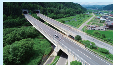
東北自動車道 十和田管内高速道路リニューアル工事
