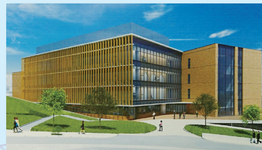
名城大学天白キャンパス研究実験棟Ⅲ・Ⅳ(仮称)新築他工事
