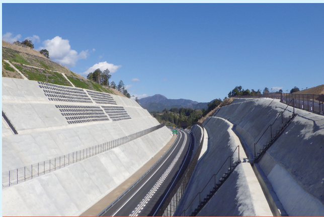
中部横断自動車道 高山工事(静岡県)
