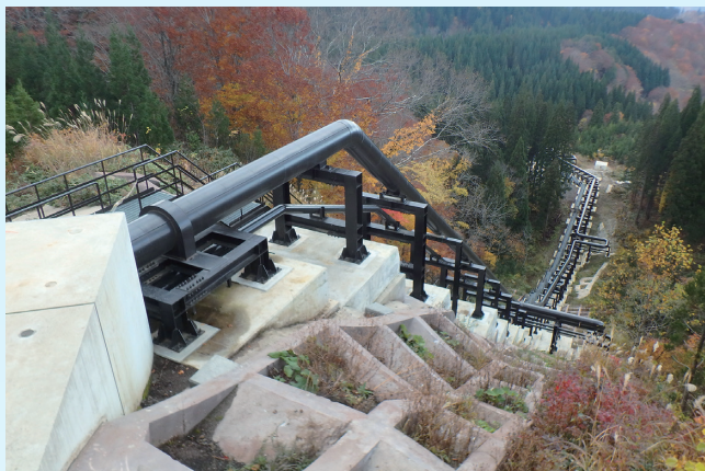
山葵沢地熱発電所 生産・還元設備工事(秋田県)
