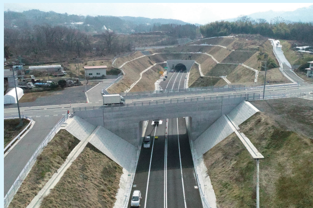
東北中央自動車道 やまがたざおうトンネル工事(山形県)
