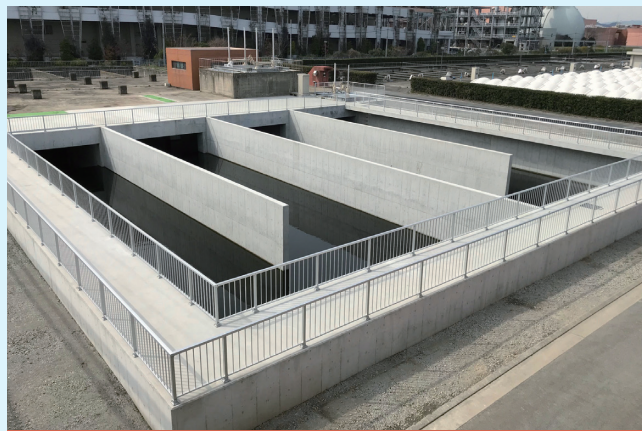
平成28年度猪名川流域下水道原田処理場塩素混和池施設築造工事(大阪府)
