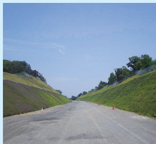
紀北西道路上野地区他改良工事
