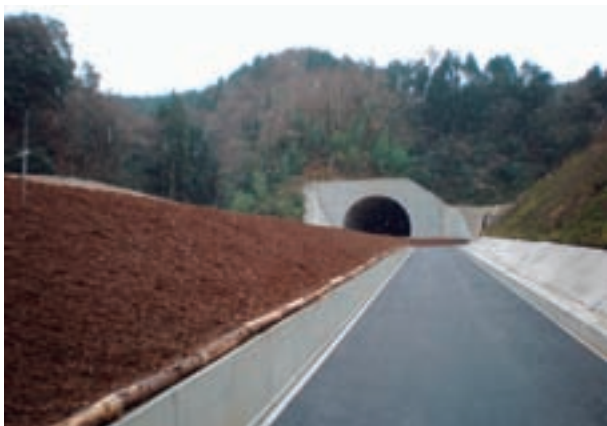
上熊谷トンネル（島根県）
