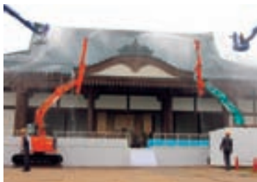
（技術研究所での降雨試験の様子）
