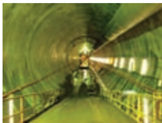
（三本木原トンネル坑内全景）
