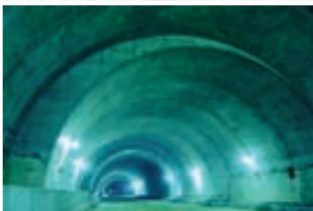
（箕面トンネル坑内全景）
