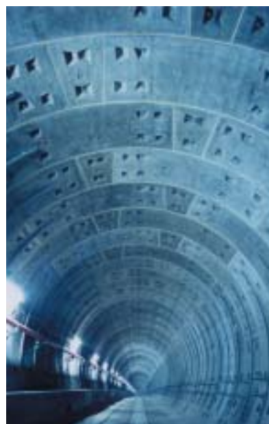
台北市地下鉄土城線 建設工事CD551工区 (台湾)
