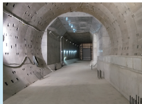
北大阪急行線の延伸事業のうち土木工事
