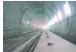
東北新幹線 二戸トンネル工事 (岩手県) 日本鉄道建設公団が進める東北新幹線工事の盛岡と八戸の区間にあり、掘削にNATM工法、ショートベンチカット工法を採用した、全長3,330メートルのトンネルです。
