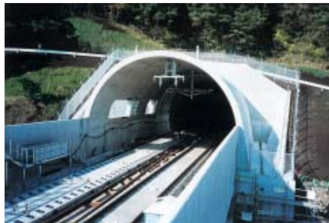
東北新幹線 二戸トンネル工事 (岩手県) 日本鉄道建設公団が進める東北新幹線工事の盛岡と八戸の区間にあり、掘削にNATM工法、ショートベンチカット工法を採用した、全長3,330メートルのトンネルです。
