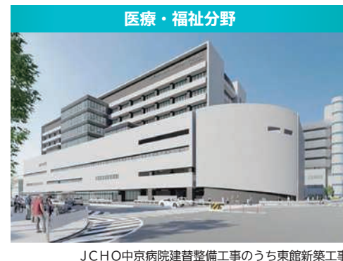
JCHO中京病院建替整備工事のうち東館新築工事
