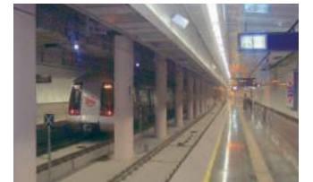
デリー地下鉄建設工事
