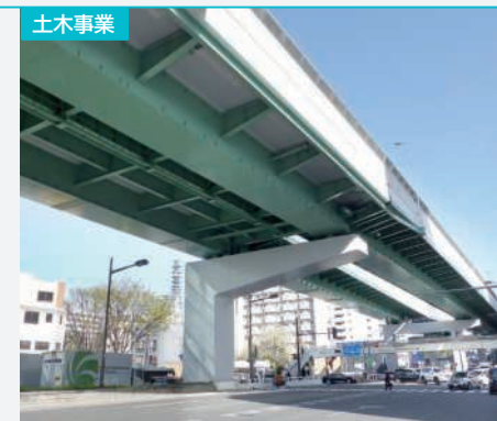
土木事業 令和元年度 高速都心環状線橋梁修繕工事 (高岳工区) (愛知県) 発注者: 名古屋高速道路公社
