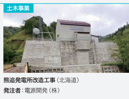
土木事業 熊追発電所改修工事(北海道) 発注者:電源開発(株) 土木事業 中部横断自動車道 吉原地区切土のり面災害復旧工事(静岡県) 発注者:中日本高速道路(株)
