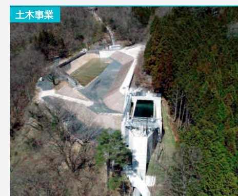
土木事業 奥津発電所改修工事のうち土木関係工事、奥津発電所改修工事に伴う除却工事(土木関係)、奥津発電所改修工事に伴う建築関係新築工事(岡山県) 発注者:中国電力(株)
