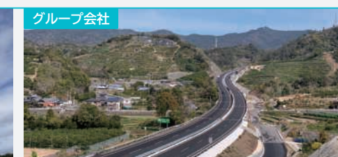
グループ会社 湯浅御坊道路 日高川舗装工事(和歌山県) 発注者:西日本高速道路(株) 施工:ガイアート
