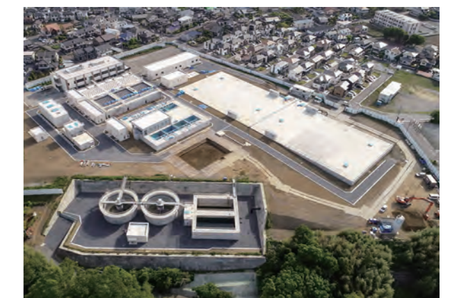
上坪浄水場更新事業施設建設工事
