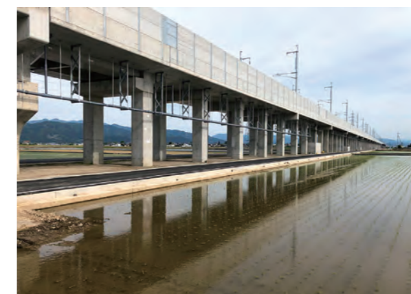
北陸新幹線坂井高架橋
