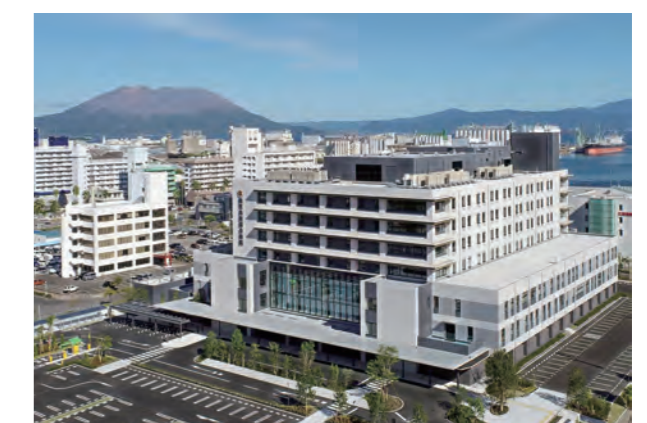
医療法人徳洲会鹿児島徳洲会病院移転新築工事
