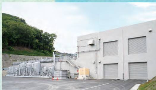
浸出水処理施設
