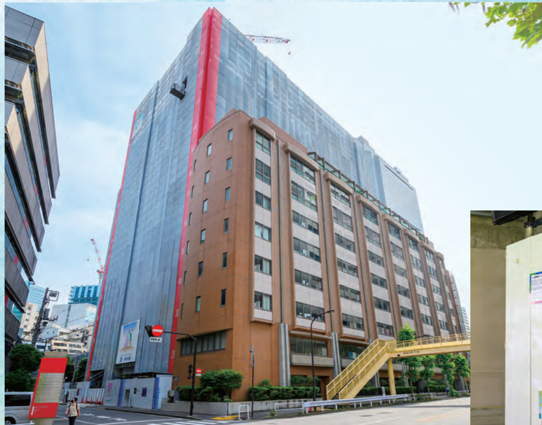
手前の既存校舎で授業を行いながら、奥の新校舎を建てていく“居ながら工事”を実施
