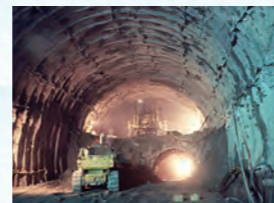
1977年 上越新幹線中山トンネル貫通
