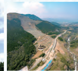
2017年 阿蘇大橋地区 斜面防災対策工事
