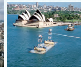
1992年 シドニー・ハーバー・トンネル 供用開始
