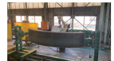
セグメント搬送装置と自動グラインダロボット
