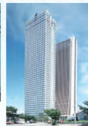
1978年 新宿野村ビル竣工
