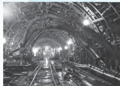
1958年 黒部川第四発電所・大町トンネル貫通
